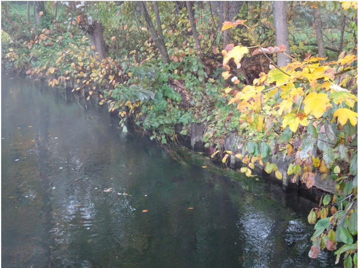
Abb. 6: Spundwand/Betonsteine entlang des Würmuferes.
