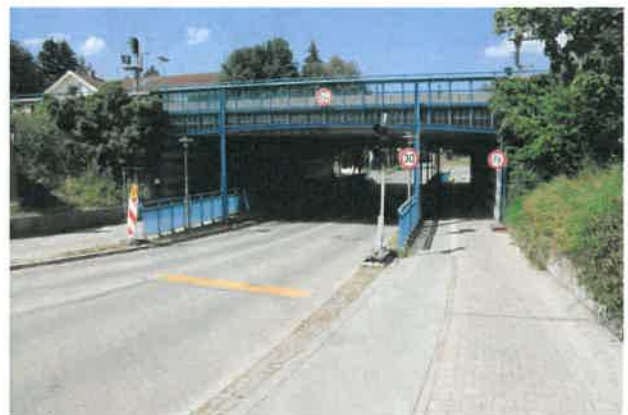
Unterführung Bhanhofstraße | Pippinplatz
