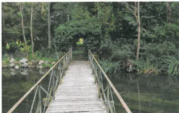
4 Brücke über Würm
