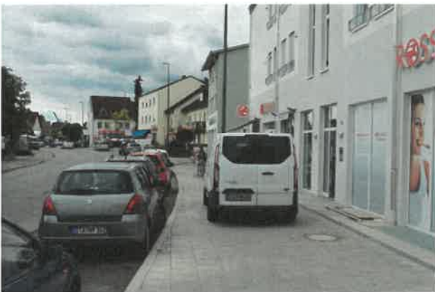
mangelhaft gestaltete öffentliche Parkplätze an Sarnberger Straße
