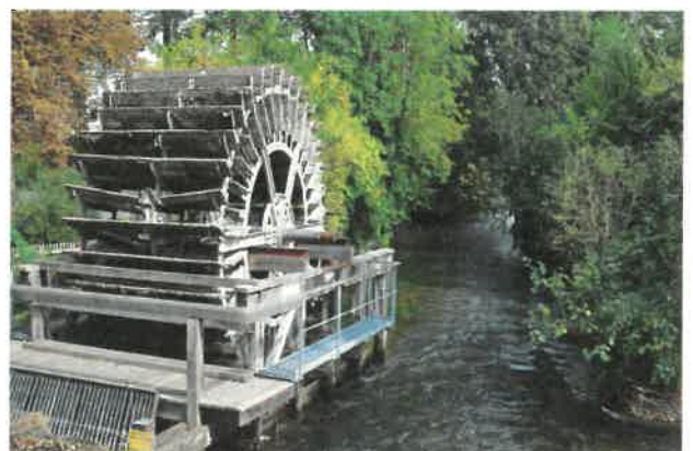
Wasserrad der ehemaligen Papiermühle
