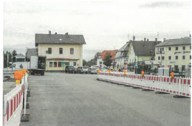
Zustand heute Bereich Busbahnhof
