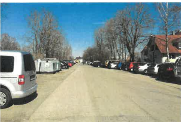
aktuelle P+R Situation am Bahnhof
