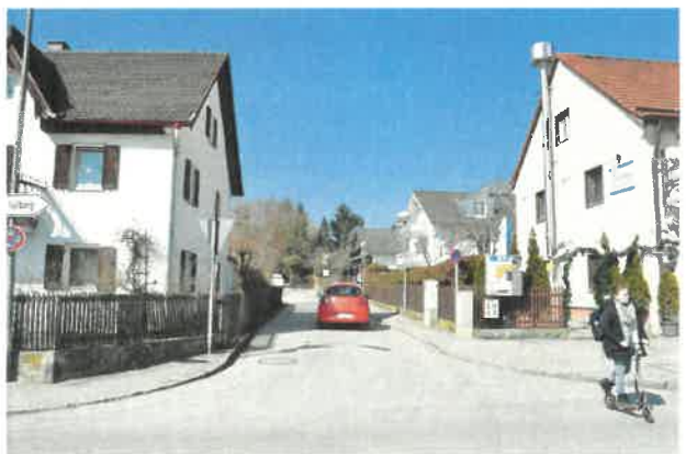
mangelhaft gestalteter Fußweg entlang Balthasar-Vizthum-Straße
