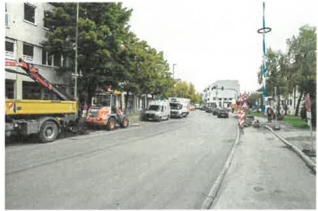
mangelhafter Verkehrsknotenpunkt Bahnhof-, Sarnberger, Münchener Straße
