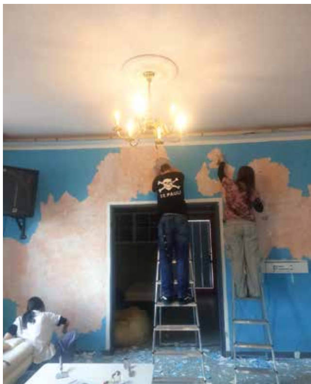
Renovierungsarbeiten im Februar
