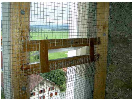
Abb. 4: Links oben: Einflugsmöglichkeit nach dem Umbiegen des Gitters (Pfeil). Der umbogene Teil sollte dicht an dem dahinter befindlichen Gitter anliegen, damit sich die Tiere nicht im Spalt verfangen können (Maßangaben in mm). Mitte oben: Einflugsöffnung am Dachansatz (zwischen Dach und Mauer). Rechts oben: Tote Fledermaus in einem Gitter mit mittlerer Maschenweite. Unten: Öffnung im Gitter eines Turmfensters mit Anflugbrett.
